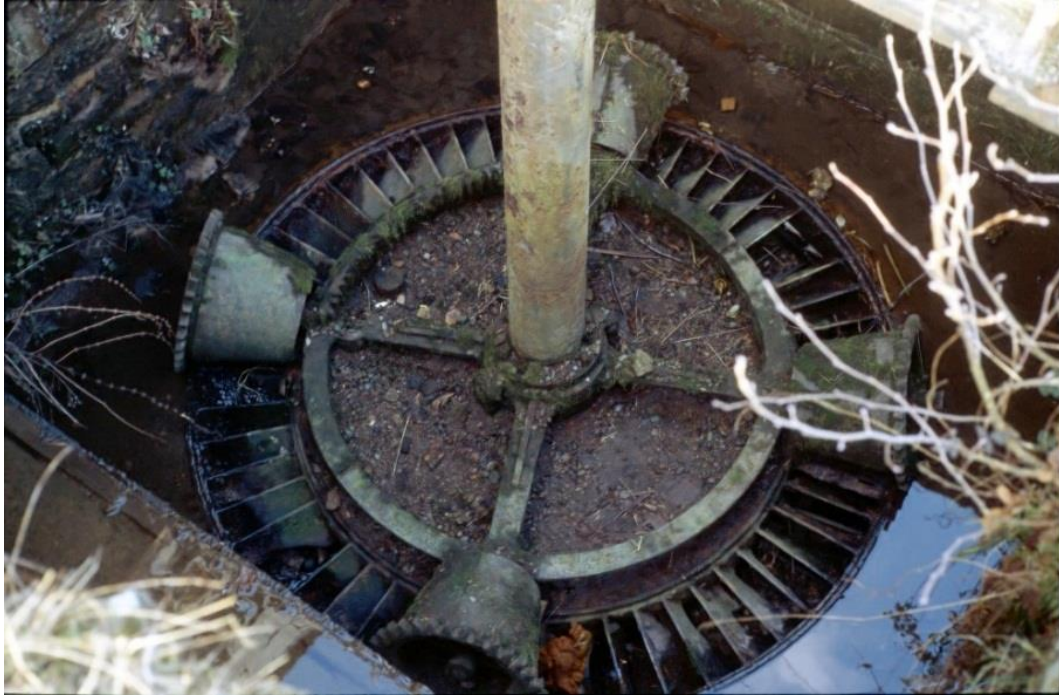
Turbine Fontaine, encore en place en 2000, qui date du milieu du XIX e siècle, à Breuchotte (ancienne usine Forel).
