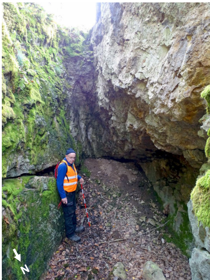
Vue prise depuis le fond du défilage. La galerie située au fond a été entièrement comblée. On aperçoit l'espace créé par tassement des matériaux entre la voûte et le remblais.
