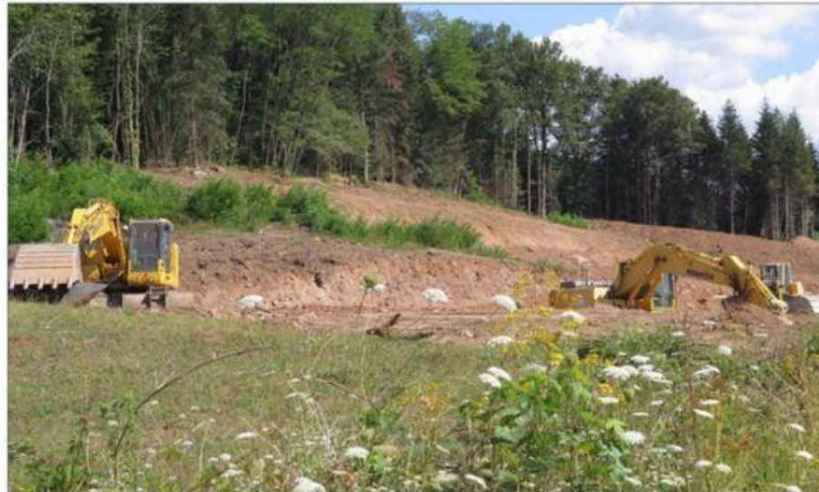
Le long de la D 486, le chantier de terrassement en vue de la construction d'un hangar et d'un site de stockage pour une société forestière interpellé l'archéologue Denis Morin. Photo ER/Alain ROY
