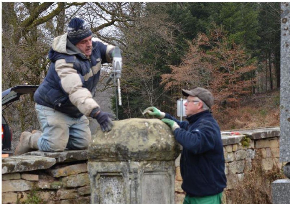
Forage et pose d'une broche en acier avant assemblage.
